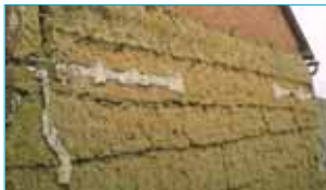
Mur en bauge. Broué.
