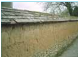
Mur en terre crue, soubassement silex. Broué.
