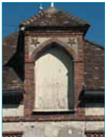
Lucarne engagée dans le mur (dite pendante), maçonnée, à croupe.
