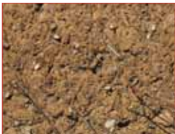
Couleur et texture de la bauge.
