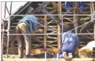
Application du torchis sur la structure secondaire avant de remplir les "vides intersticiels".
