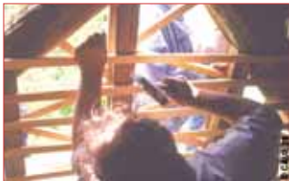
Chantier de restauration d'un mur en torchis : réparation de la structure secondaire à éclisses et barreaudage.
