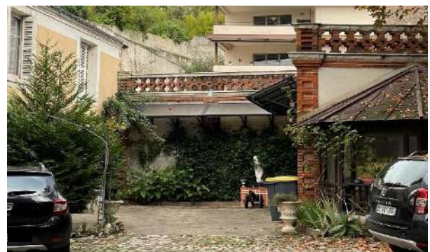
Panneaux installés sur des consoles métalliques formant une sorte de marquise positionnée le long d'un bâtiment sur cour à Saint-Cyr-sur-Loire (37).
