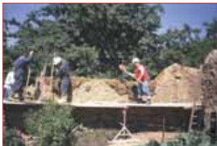
Préparation pour la mise en œuvre d'une levée supplémentaire.
