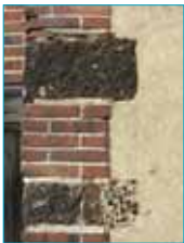
Maçonnerie en pierre de grison et brique.
